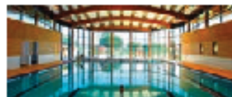
ESPACE NAUTIQUE LEO LAGRANGE BEZIERS
